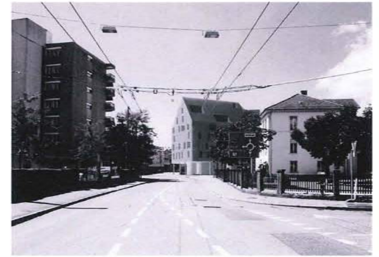
Blick entlang Poststrasse
