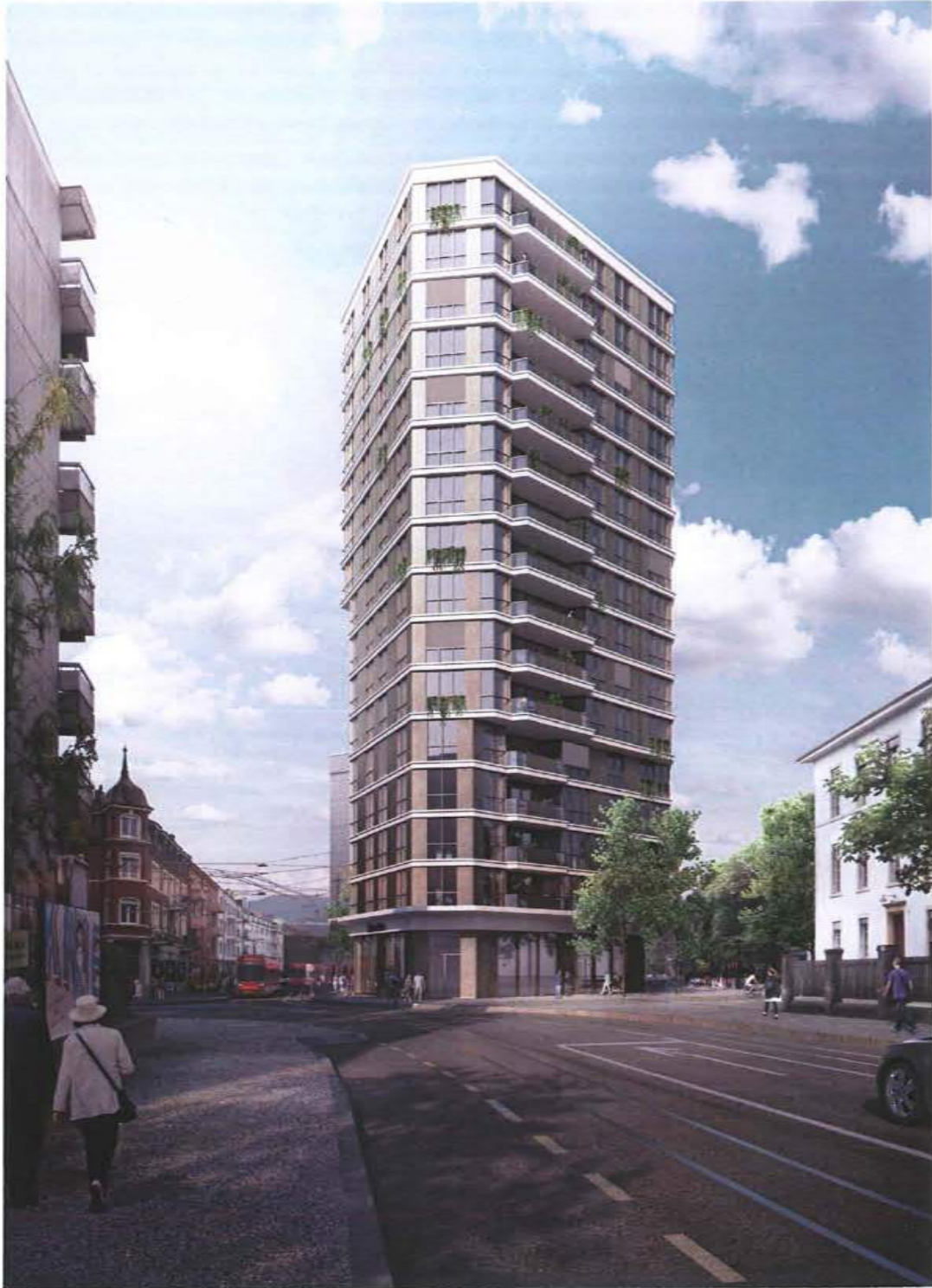
Visualisierung: Ein neues Tor zur Stadt. Der Park öffnet sich zum Strassenraum.
