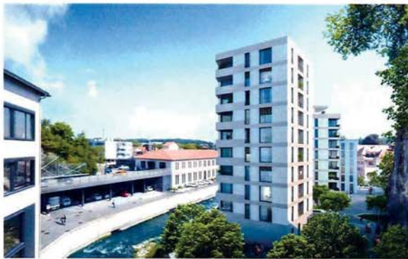
Wasserkühler-Sicht vom Gewerbestraße
