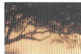
Waldach Südseite/ Dach und Unterseite Trapezblech 0,7 Kupfer
