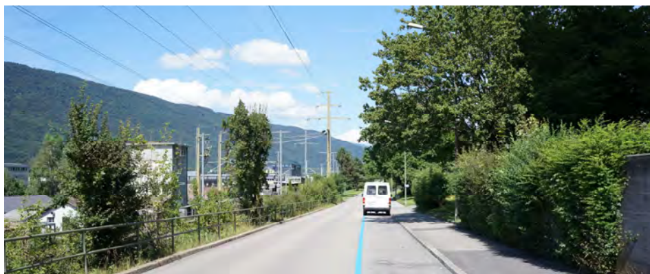
Ligne haute tension le long du chemin Mettlen
