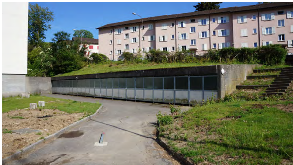
Le mur de soutènement à l'ouest de la maison-tour
