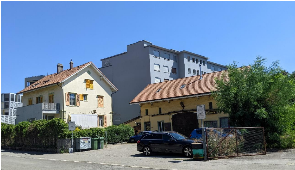
Fotografie des Planungsbereichs, Sicht vom Fischerweg
