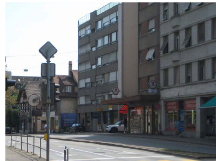
Emplacement non admissible : saillie de façade.
