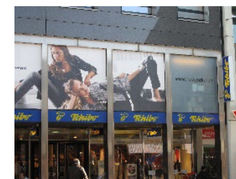
Sollicitation excessive de la façade d'immeuble.
