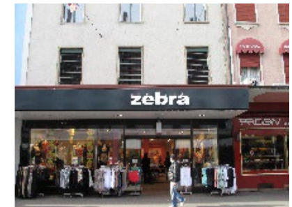
Lettres lumineuses découpées apposées sur le front de la marquise (contexte adéquat ; admissible).
