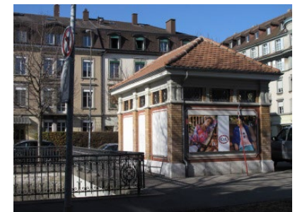
Affichage (désormais) interdit sur une façade de monument historique.
