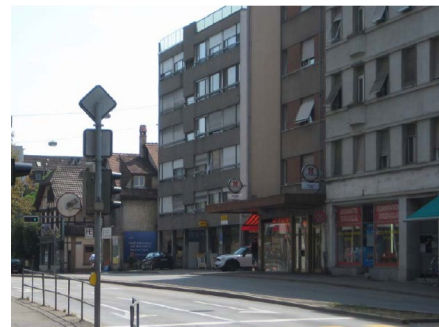
Nicht bewilligungsfähig: Standort an Fassadenvorsprung.
