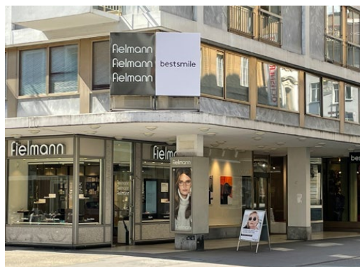
Firmenanschrift in leuchtenden Einzelbuchstaben im Erdgeschoss regelkonform. Diagonal gestellte Leuchtkästen auf der Markise wirken fremd und wuchtig, auch wenn sie die Klimageräte dahinter kaschieren (nicht mehr bewilligungsfähig)
