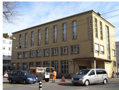
Zulässig: aufgemalte Anschrift an Post Dufourstrasse (Baudenkmal)
