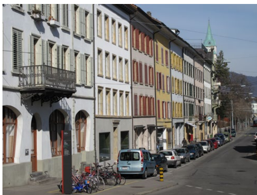
Schützenswertes Ortsbild Juravorstadt, und Teil der Baugruppe Neustadt (kantonales Bauinventar)
