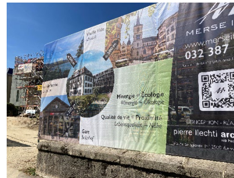
Plakat an Baugerüst zweisprachig
