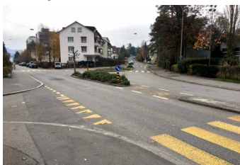
Aide à la traversée (chemin Mettlen – route du Büttenberg)
