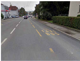
Voie réservée aux bus et aux vélos (rue de Mâche)
