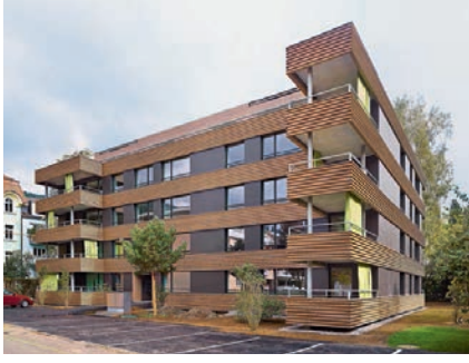
Albert-Anker-Weg 11 frisch saniert im neuen Kleid L'immeuble fraîchement rénové, dans ses nouveaux habits
