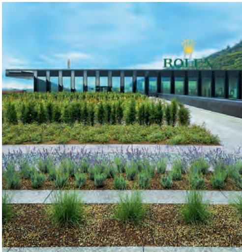
Das teilweise begrünte Dach des neuen Gebäudes verhindert extreme Temperaturen in den Produktionswerkstätten Le toit partiellement végétalisé du nouveau bâtiment permet d'éviter des températures extrêmes dans les ateliers
