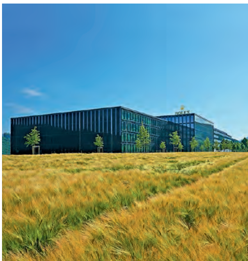
Das neue Gebäude der Manufacture des Montres Rolex S.A. im Bözingenfeld Le nouveau bâtiment de la Manufacture des Montres Rolex S.A. aux Champs-de-Boujean
