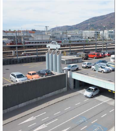
Abb. 2: Das Bahnhofparking umfasst 325 Plätze Img. 2: Le Parking de la Gare offre 325 places
